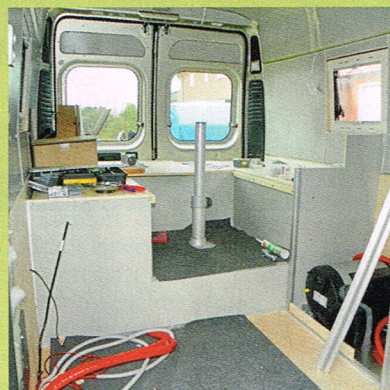
In dieser Bauphase ist die Konstruktion der Hecksitzgruppe gut zu erkennen.
